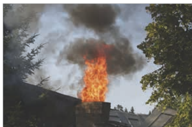
Zanedbanou údržbou komínu zvyšujete možnost vzniku požáru.
