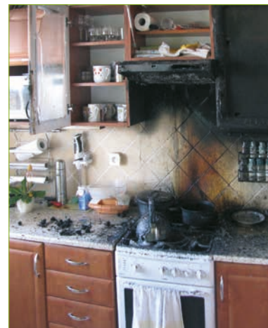
Kuchyně po požáru při vaření bez dozoru.
