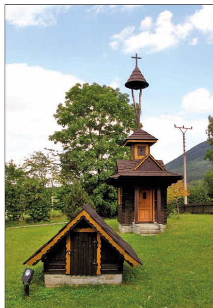
Zvonička v Karlovicích
