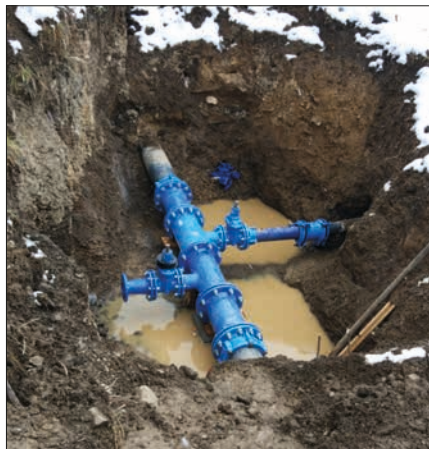
Výměna uzavíracích ventilů
