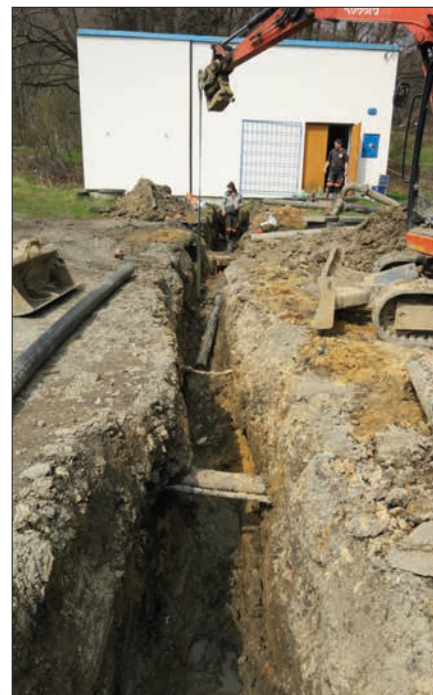
Výměna napojení na oblastní vodovod
